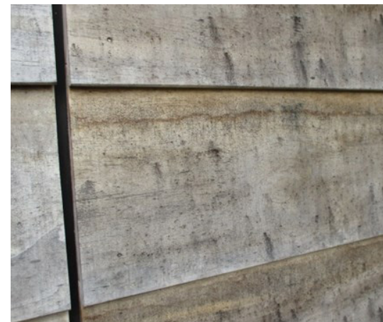
Raue gesägte Oberflächen sind der Aufbauschicht zuträglich
