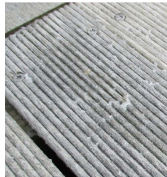
8.4 Fasern können sich in gerippten Oberflächenprofilen verfangen
